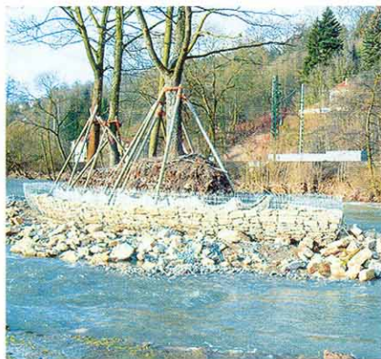
Gabionenschiff im Bau
