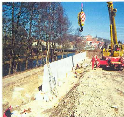
Bau der Ufermauer
